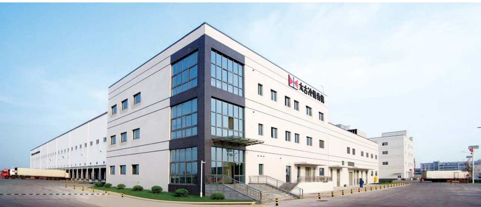
太古冷链物流上海奉贤冷库位于奉贤区海港综合经济开发区内,是太古在中国内地首个全资拥有的冷藏设施。
