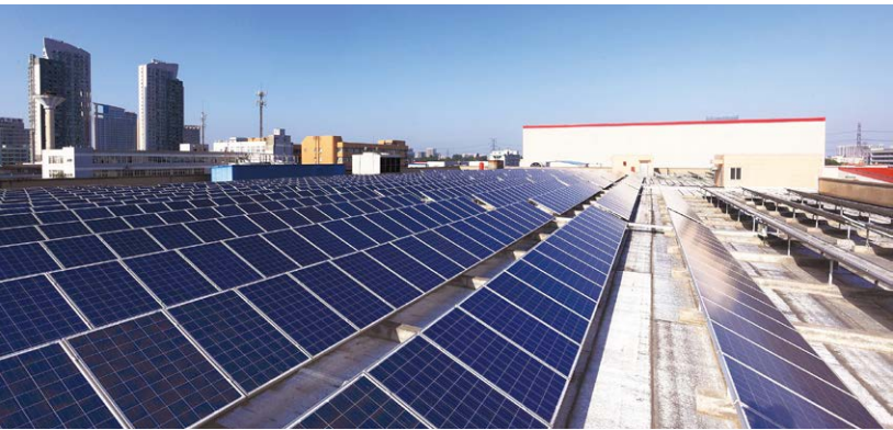
浙江太古可口可乐屋顶安装分布式光伏发电设施。
